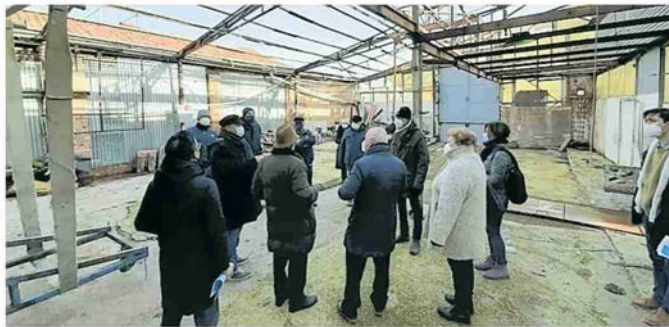
San Isepo, parzialmente abbandonato in attesa di un recupero
