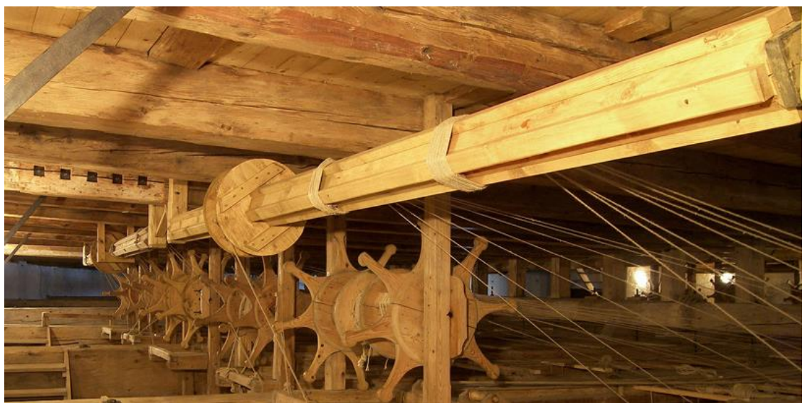
Stage machinery underneath the stage at the Castle theatre (Zámecké divadlo), Český Krumlov, Czech Republic.
